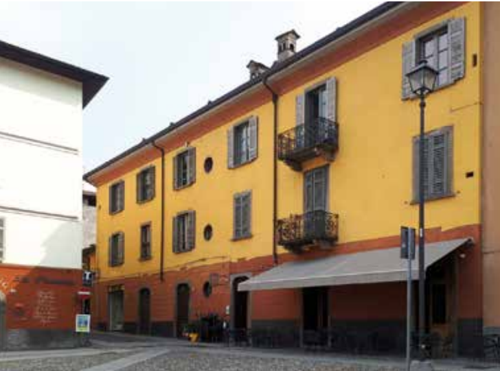
Prospetto di casa Romelli con affaccio su P.za Gen. Ronchi.
